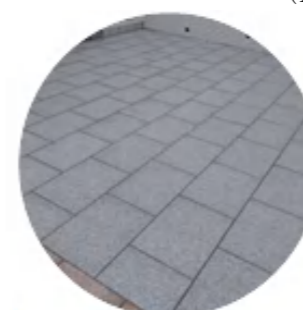
駐車スペース石張り施工
