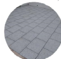
駐車スペース石張り施工
